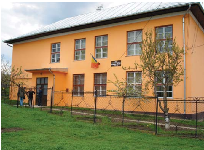
Școala din com. Frata, jud. Cluj, renovată cu fonduri strânse din Germania, printr-o inițiativă a unui fiu al satului
